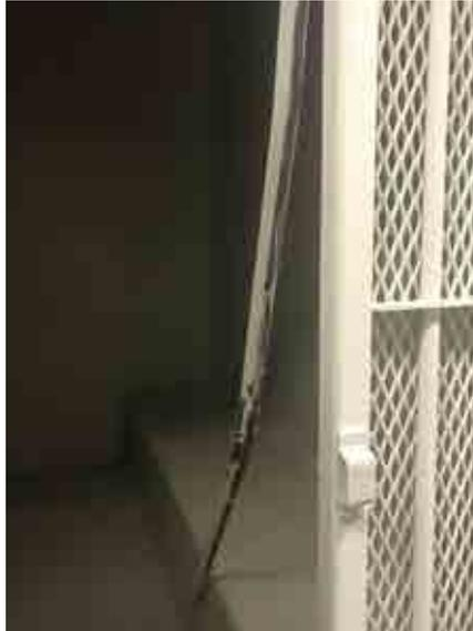
**Foto** Celdas con material desprendido de la pared que permite ver las bases del portón.
